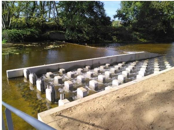
**Rampe à macro-rugosité Oust : Pont d'Oust / MOe : Sinbio SCOP ; Entreprise : La Verchéenne / 275 000€ HT**
