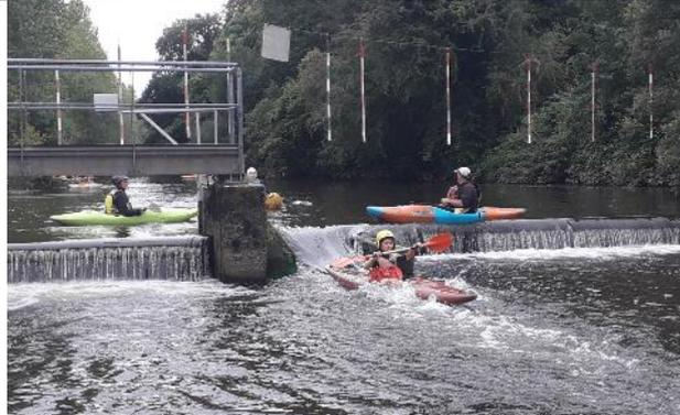
*Réalisation d'un dispositif assurant la libre circulation des poissons migrateurs et des canoés kayaks sur le seuil de la prise d'eau de Lestrez sur la rivière du Léguer*
