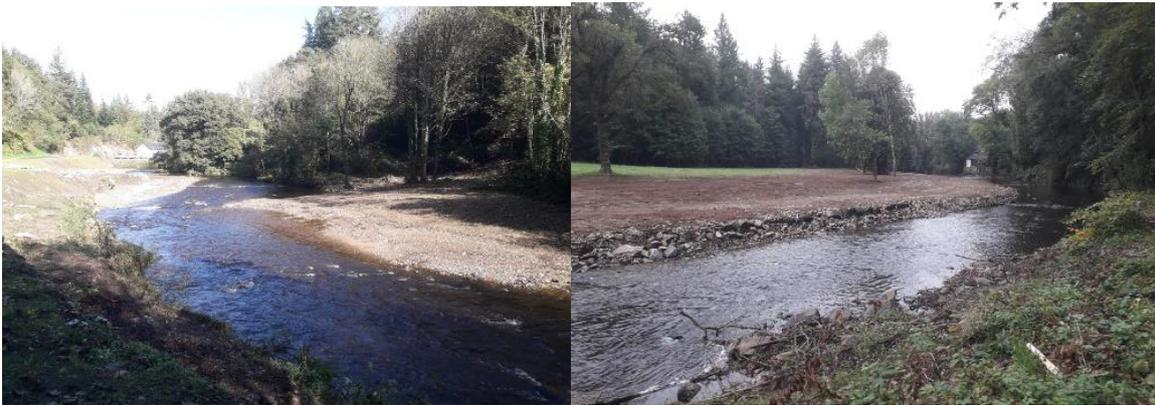
*Effacement d'un seuil et renaturation complète du Léguer sur 600m (reprofilage berge au niveau d'anciens canaux d'amenée et fuite) + aménagement gîte chauve-souris*
