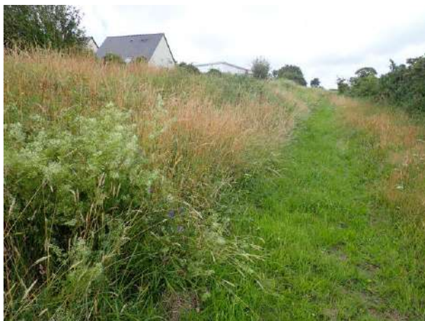
Figure 10 : Chemin sur la levée à l'ouest du terrain de football (Mael GARRIN / GREZIA)
